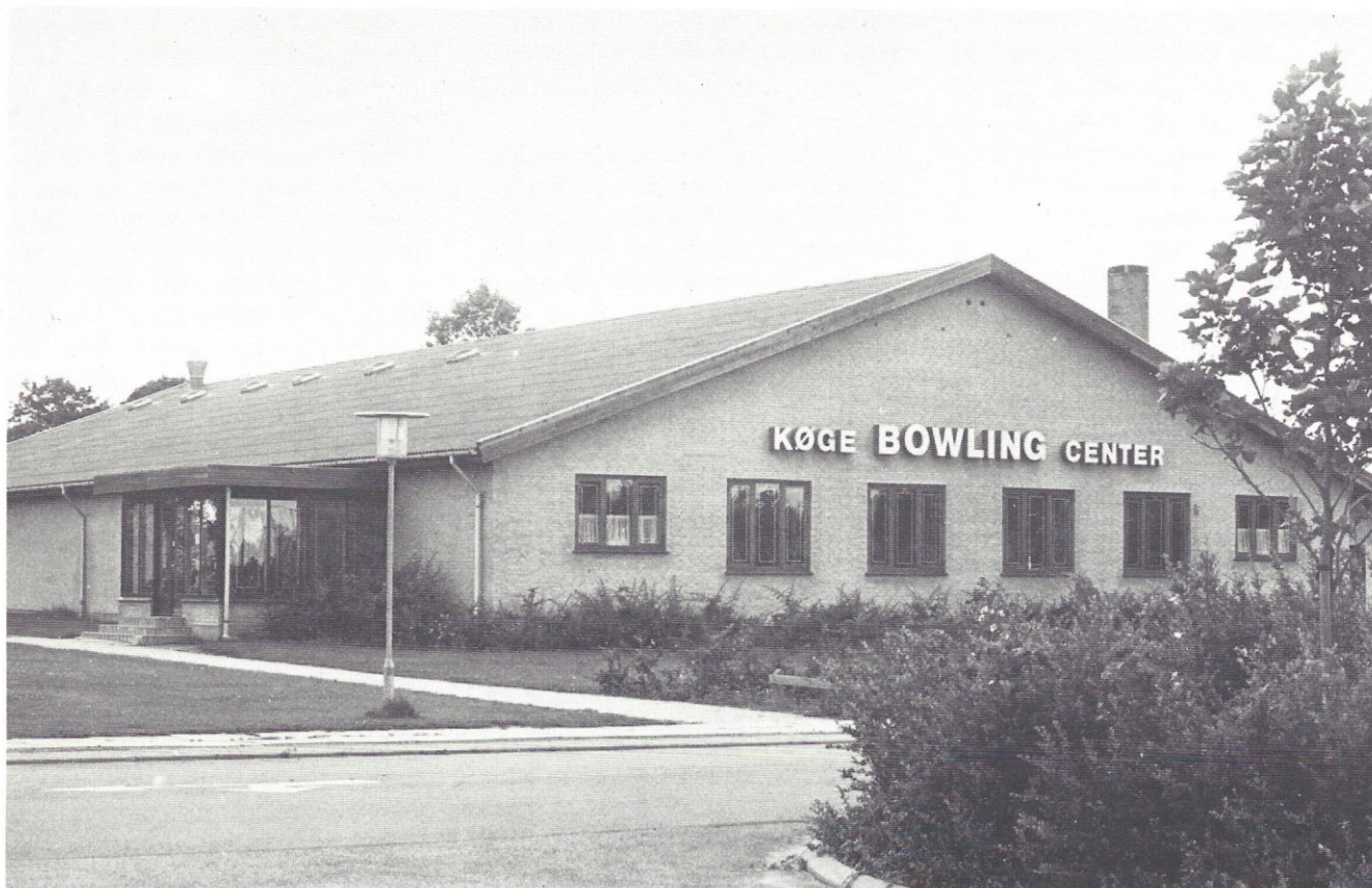
Køge Bowling Center. En smuk bowlinghal i en smuk bygning.
