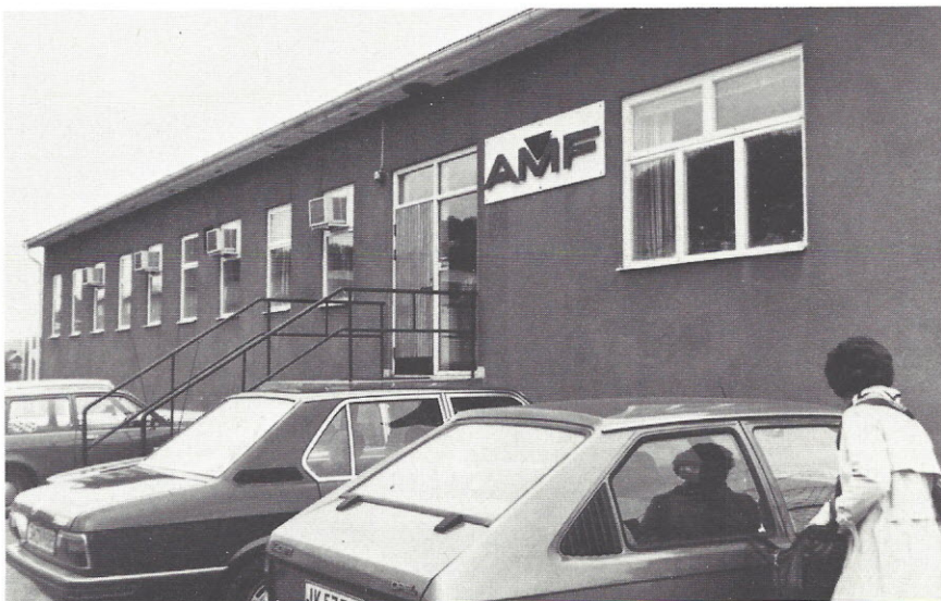
AMFs hovedsæde i Skandinavien. Administrationsbygningen er ikke imponerende, men til gengæld arbejdedes der imponerende effektivt bag facaden.
